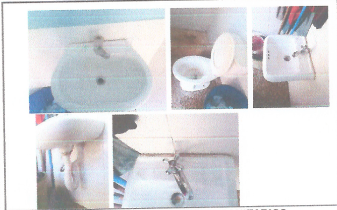
Foto 1: REMOZAMIENTO DE SERVICIOS SANITARIOS
