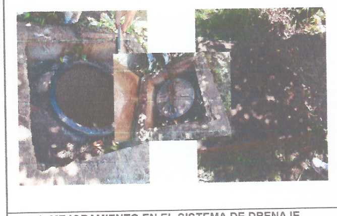
Foto 4: MEJORAMIENTO EN EL SISTEMA DE DRENAJE
